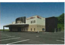
6号館 メモリアルホール紫蘭結きょう
