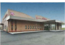
4号館 メモリアルホール紫蘭都祁
